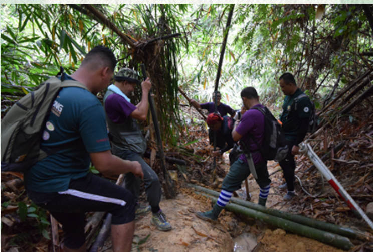
Membuat longkang bagi memastikan laluan tidak terhakis
