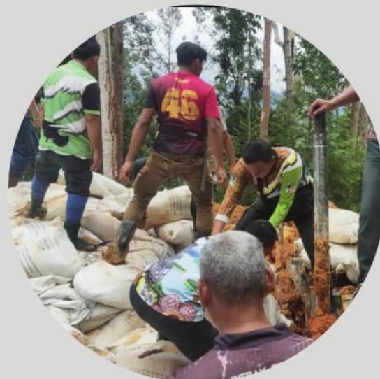
Longgokan Ammonium sulfate di bawa keluar untuk dimusnahkan
