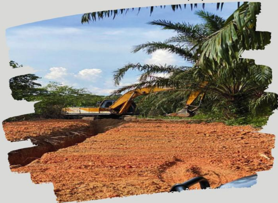
Kerja-kerja pembinaan parit pemisah diantara HSK dan tanah milik
