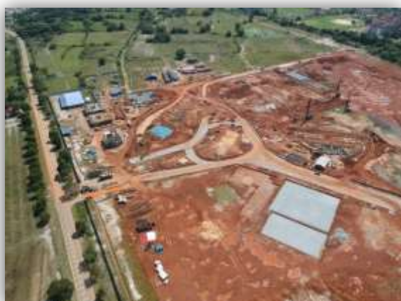
Keadaan tapak semasa kerja-kerja binaan baru bermula
