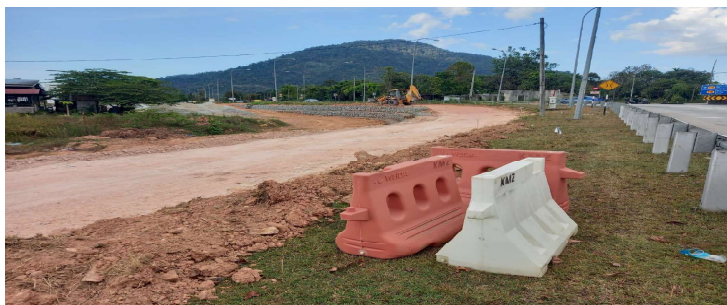
Pelaksanaan Projek Membina dan Menaik taraf Tiga Persimpangan Jalan Bagi Pembangunan Sungai Namek.
