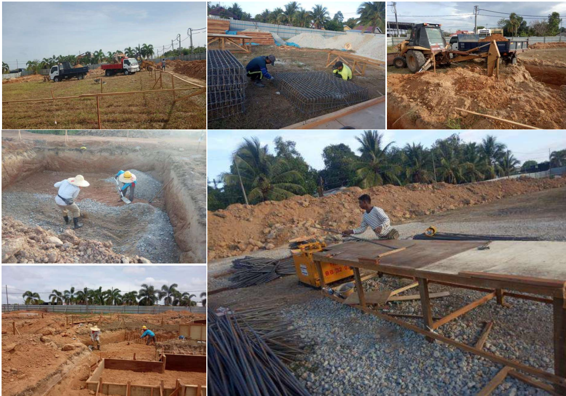
Gambar Kerja-Kerja di Tapak.
