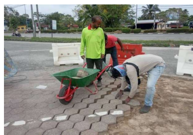
Gambar Kerja-Kerja di Tapak.
