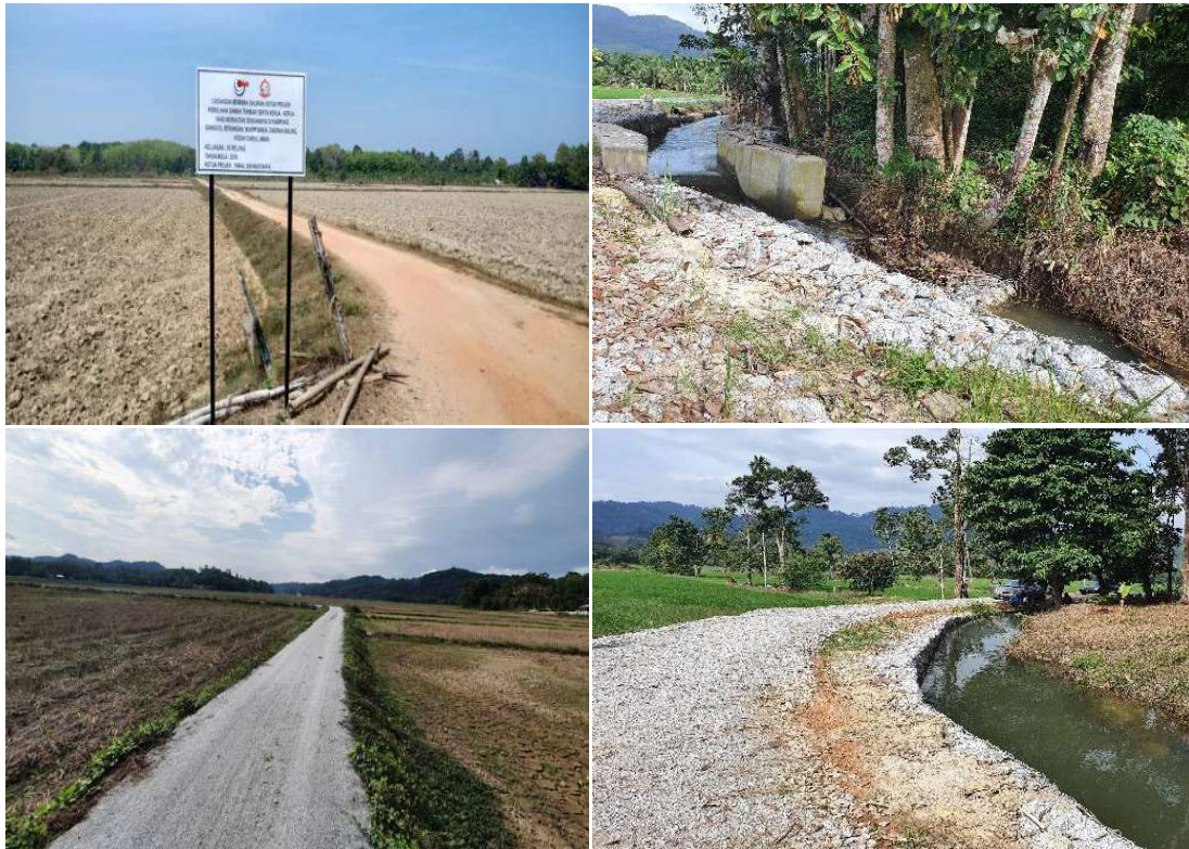
Pembangunan Prasarana Jalan Pertanian dan Pembangunan Lain-lain Infrastruktur Projek
