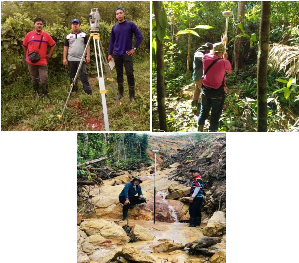
Gambar Ketika Kerja-Kerja Ukur Tanah Dilakukan
