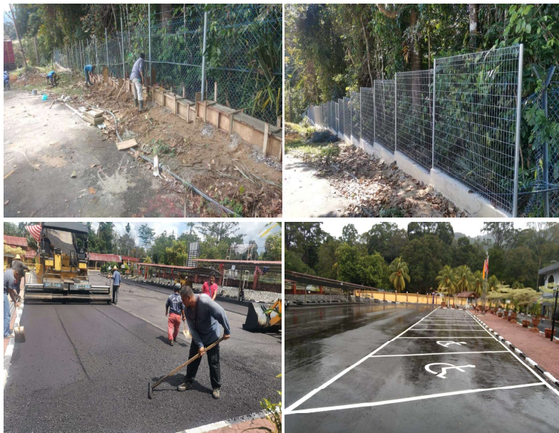
Pembinaan Sebuah Blok Sokongan Baru dan Ubahsuai Blok Tun Razak Serta Infrastruktur Berkaitan di Kolej KEDA, Daerah Sik, Kedah Darul Aman.
