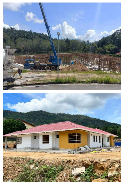
Bangunan Sokongan Baru
