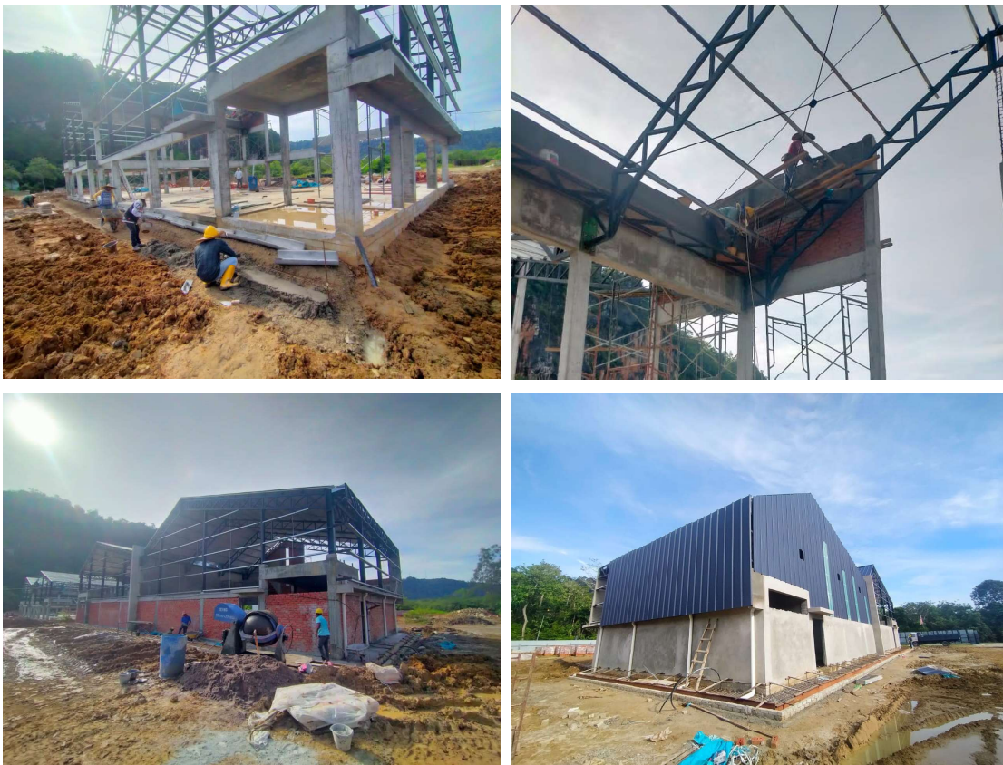
Gambar Kerja-Kerja di Tapak
