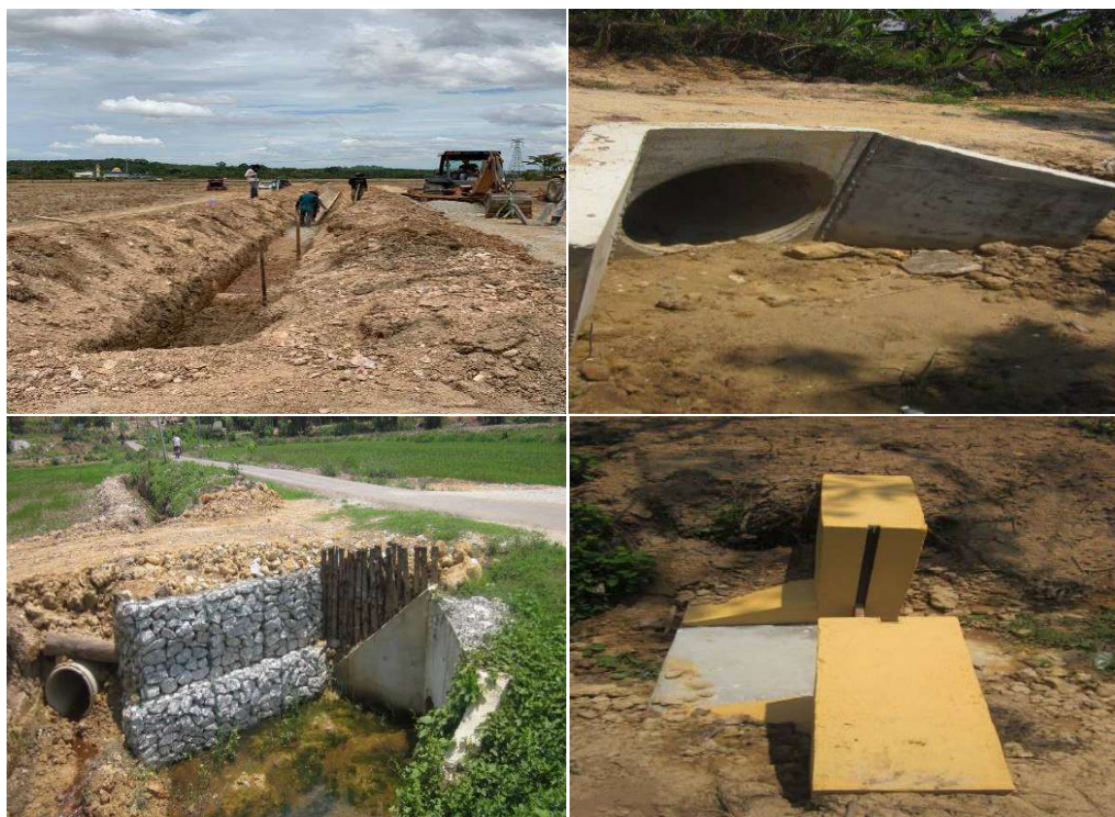
Pembangunan Prasarana Sistem Perparitan
