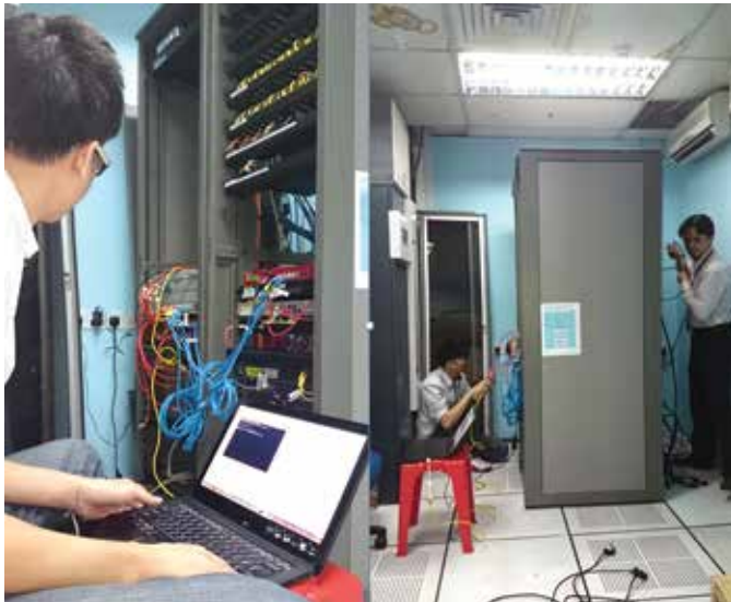
Sekitar Pemasangan Perkakasan Firewall di Bilik Server 1, Aras 2 Ibu Pejabat JMM
