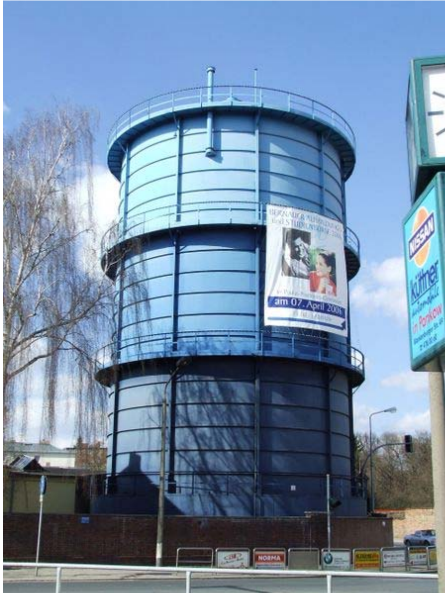
Gasometer at Bernau bei Berlin Germany
