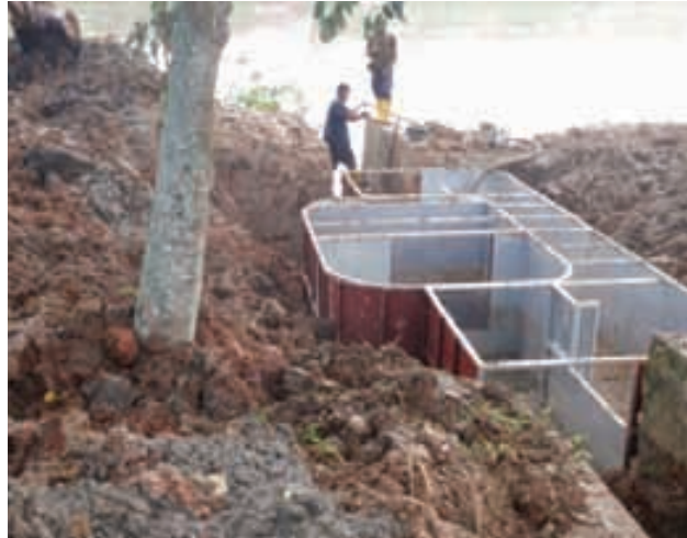
Pemasangan produk inovasi SMADRAT di lapangan
