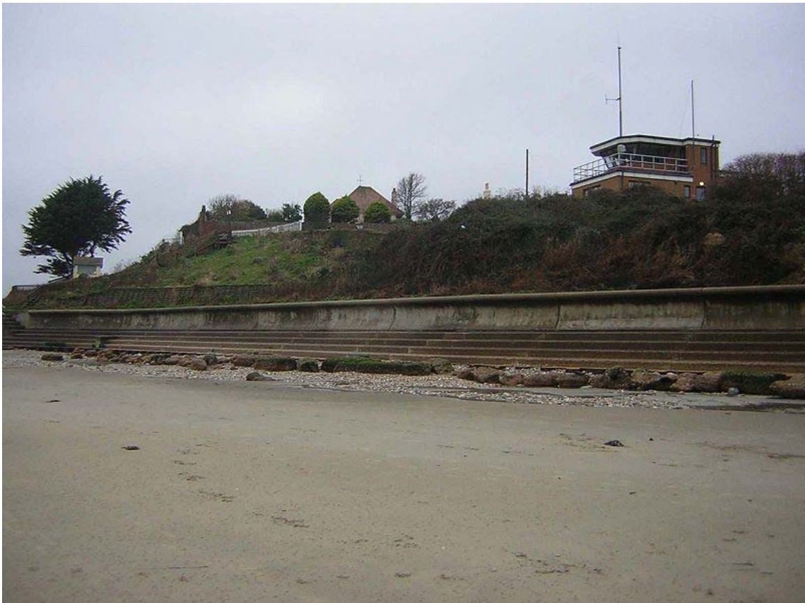
Seawall in Bembridge, UK
