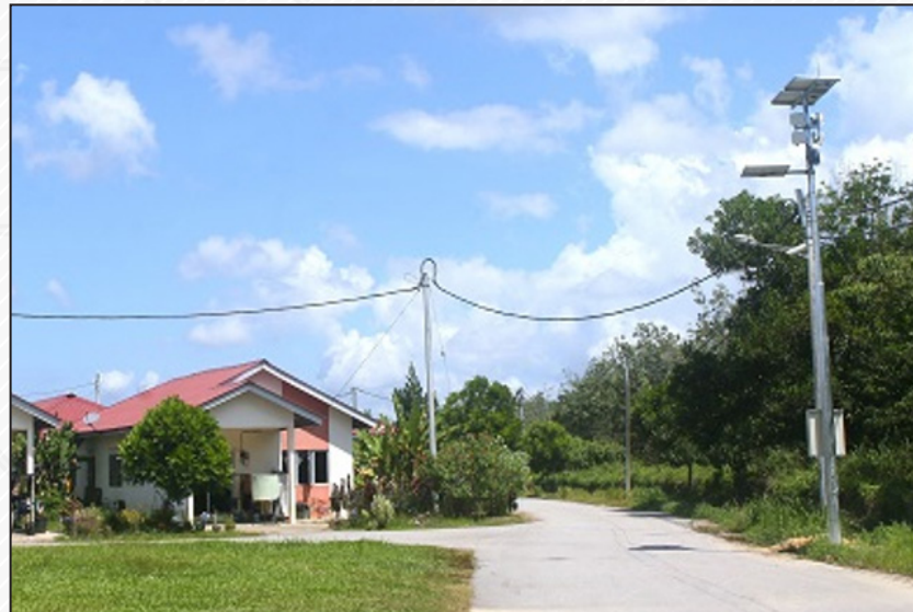
29.2 Pemasangan sistem iComm di Kg. Padang Rumbia, Pekan, Pahang.
