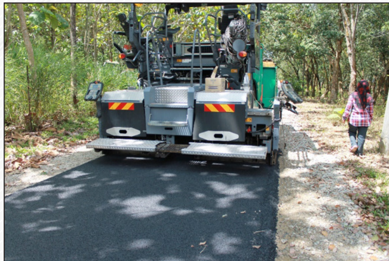
1.5 Proses penurapan jalan raya menggunakan bahan FMA.
