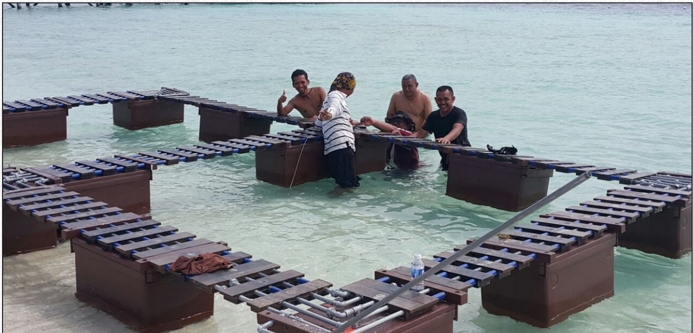
16.2 Pemasangan sangkar ikan.
