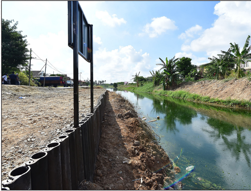
4.4 Pancang RIVERPROTEC™ digunakan untuk memperkuat struktur tebing.
