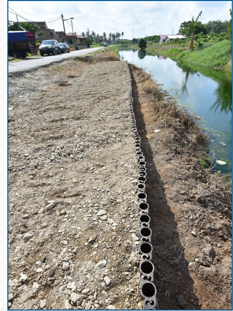
4.4 Pancang RIVERPROTEC™ digunakan untuk memperkuat struktur tebing.
