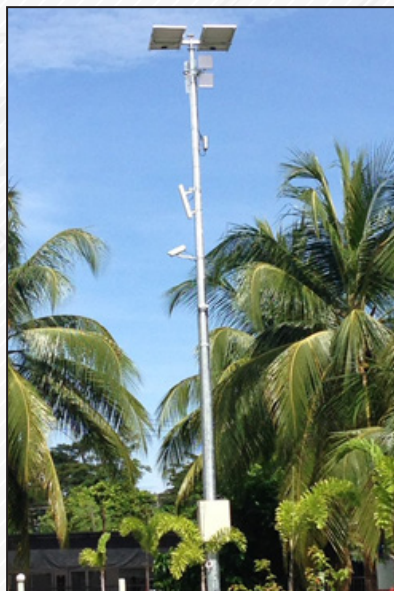
29.3 Pemasangan sistem iComm di Tuaran, Sabah.
