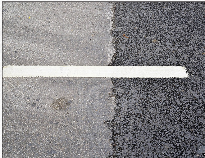
1.2 Perbezaan jalan raya yang turap dengan FMA (kanan) dan tanpa FMA (kiri).
