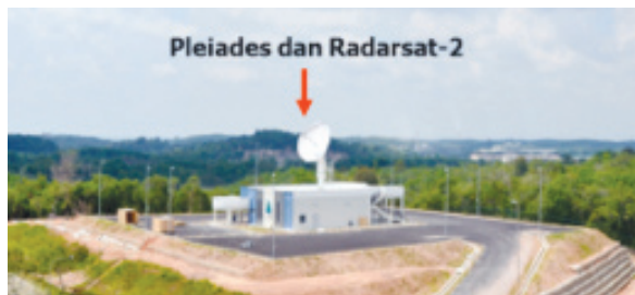
Sistem antena 7.3m yang menerima data satelit beresolusi tinggi
