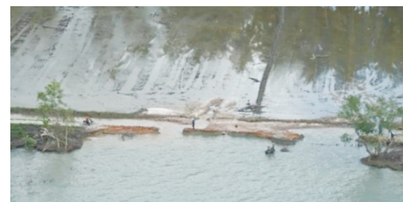
Pemantauan tebing yang pecah akibat bencana banjir pantai di Kuala Muda, Kedah.
