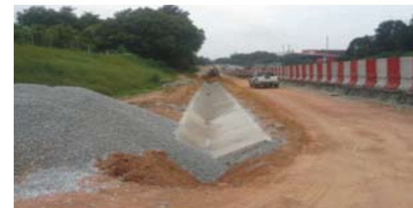
Kerja-kerja pembinaan sistem saliran
