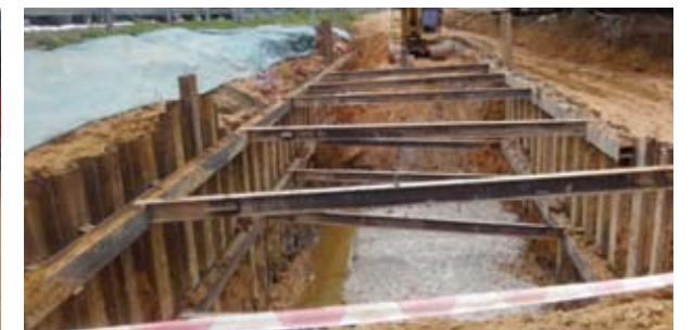
Kerja-kerja penyediaan sistem perlindungan sementara untuk pembinaan tembok penahan RC di kawasan tambahan
