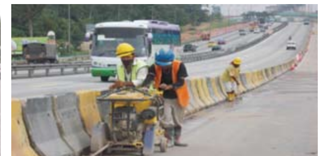
Kerja-kerja pemotongan turapan di lorong kecemasan
