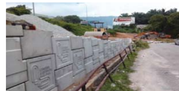
Kerja-kerja pembinaan retaining wall
