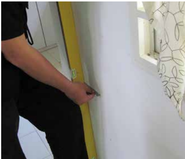
Pengujian ke atas kepugakan dinding
