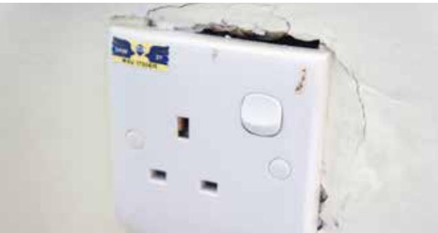
Mutu kerja lepaan dinding semasa pemasangan soket
