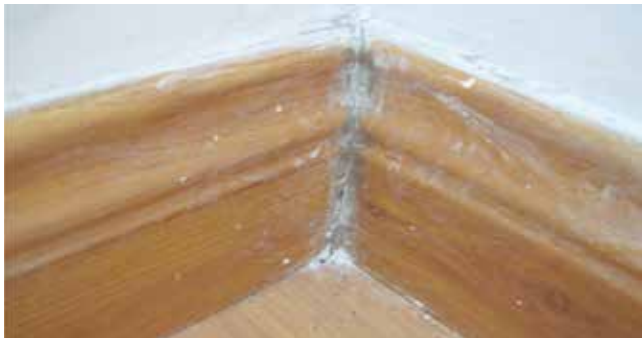
Sambungan skirting kayu yang tidak sempurna
