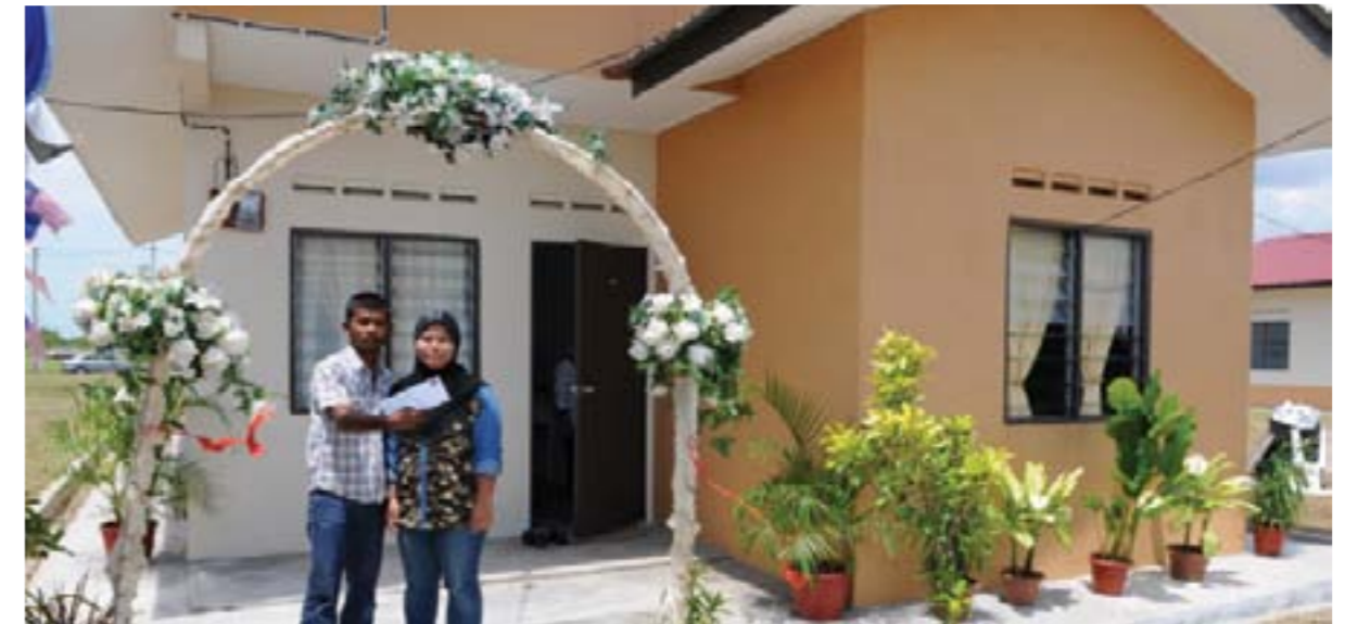
Di antara unit rumah yang telah siap dibina
