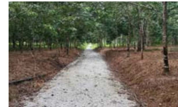
Pembinaan Jalan Pertanian [crusher-run] di projek TSB Teluk Yu, Mukim Bohor, Langkawi, Kedah
