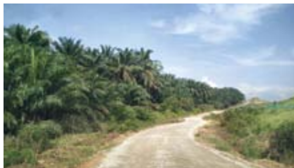
Jalan Akuakultur Sg. Lebam – Sg. Layau yang telah siap dilaksanakan.
