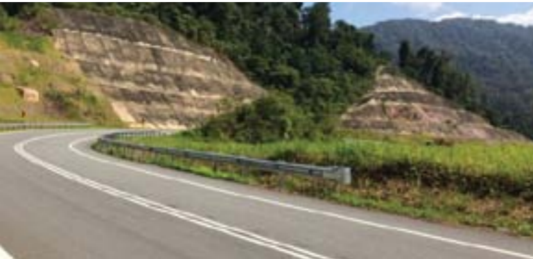
Jalan Dari Kg. Pagi Ke Kg. Mat Daling [Fasa 1]
