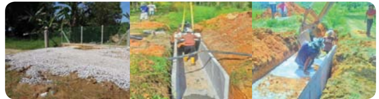
Menaiktaraf jalan pertanian / ladang sepanjang 3,600 meter dan kerja-kerja berkaitan di Ladang Integrasi Charuk Tualang, Sik.
