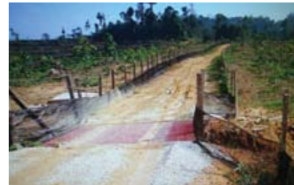
Pembinaan jambatan besi di projek TBKG Pulau Santap, Janda Baik, Bentong, Pahang
