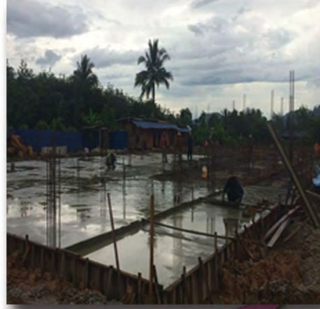
Kerja konkrit lantai bawah
