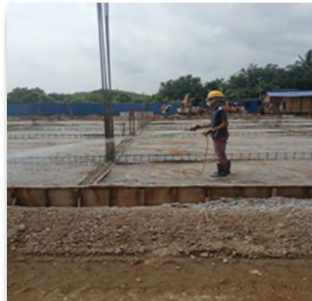
Penyemburan antitermite
