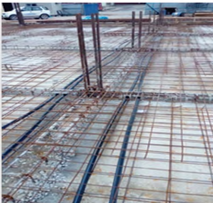
Pemasangan BRC dan paip dalaman
