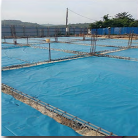
Pemasangan plastik biru
