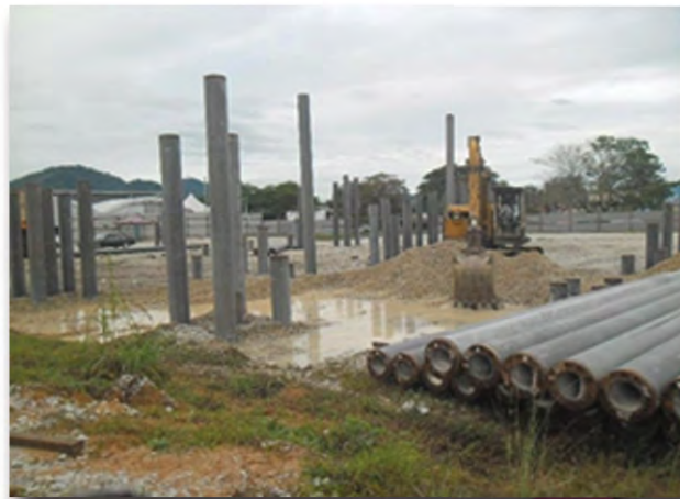
Kerja-kerja penanaman cerucuk
