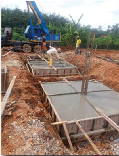
Kerja-kerja konkrit footing
