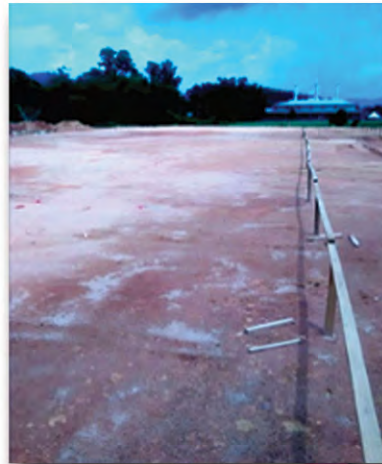
Kerja-kerja penandaan tapak bangunan
