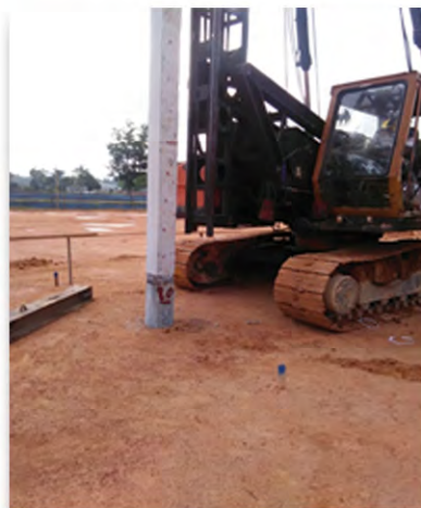
Kerja-kerja penanaman cerucuk
