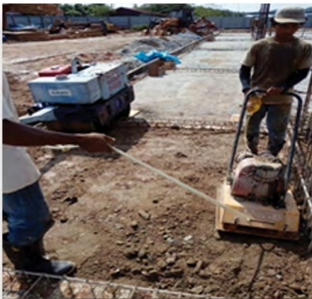
Kerja memadatkan crusher run
