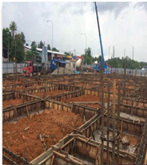
Pemasangan rasuk tanah
