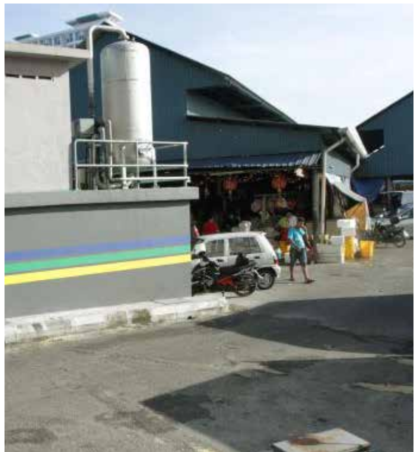
Loji rawatan air sisa (WWTP) yang khusus untuk pasar awam Jalan Klang Lama
