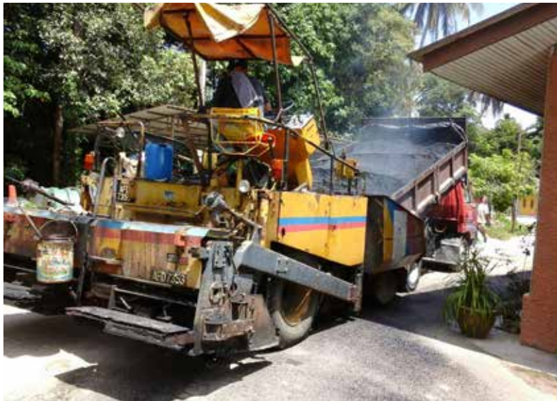
Kerja-kerja penyelenggaraan jalan di Jalan Madrasah Lebai Che Will Wakat Bharu, Kelantan
