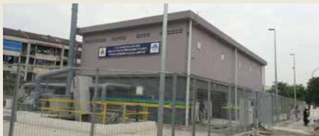
Loji Rawatan Air Sisa Kuala Lumpur membersihkan sisa air dari pasar awam ke dalam kelas IIb
