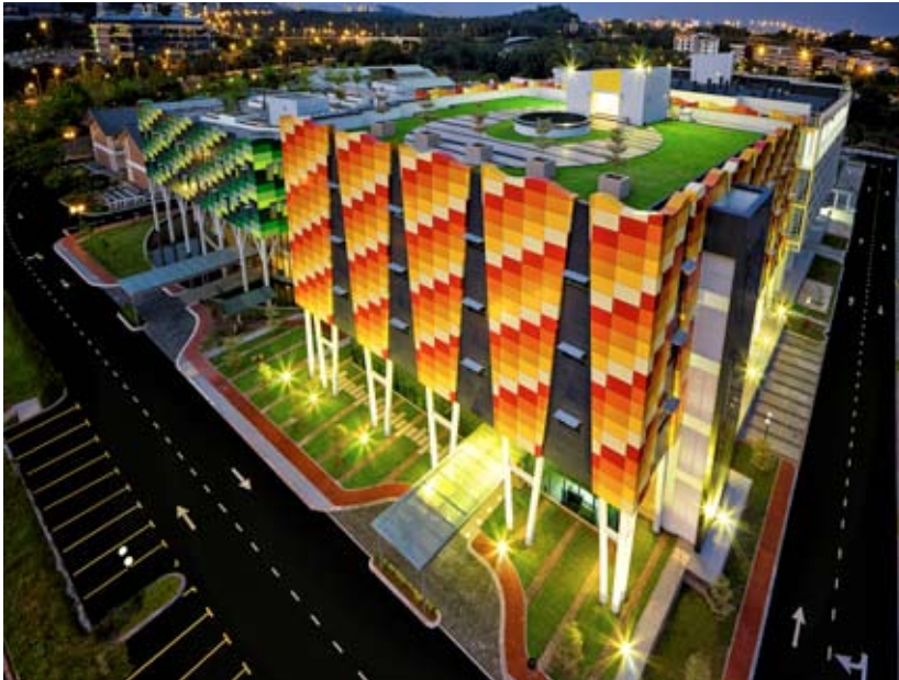
Pusat Data yang keempat milik NTT Communications dilancarkan di Cyberjaya pada Mei 2014
