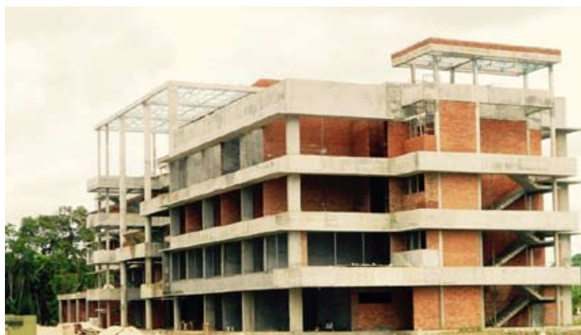
Fasiliti perkhidmatan penjagaan kesihatan milik Eden-on-the-Park yang sedang dibina
